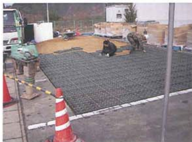
芝生保護材敷き設
