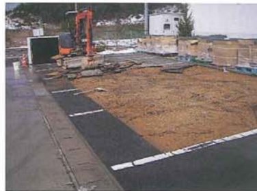
アスファルト剥がし
