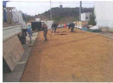
客土敷き完了
