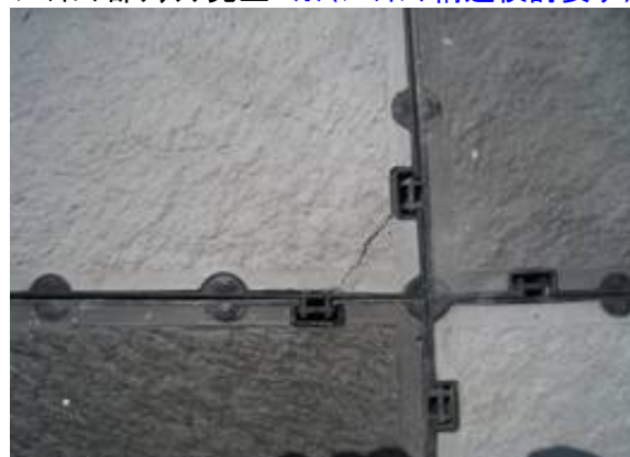
ジョイント部クラック発生 ※(ジョイント構造検討要す)
