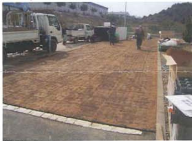
芝生転圧完了
