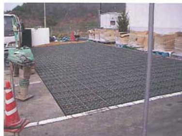
芝生保護材敷き設完了
