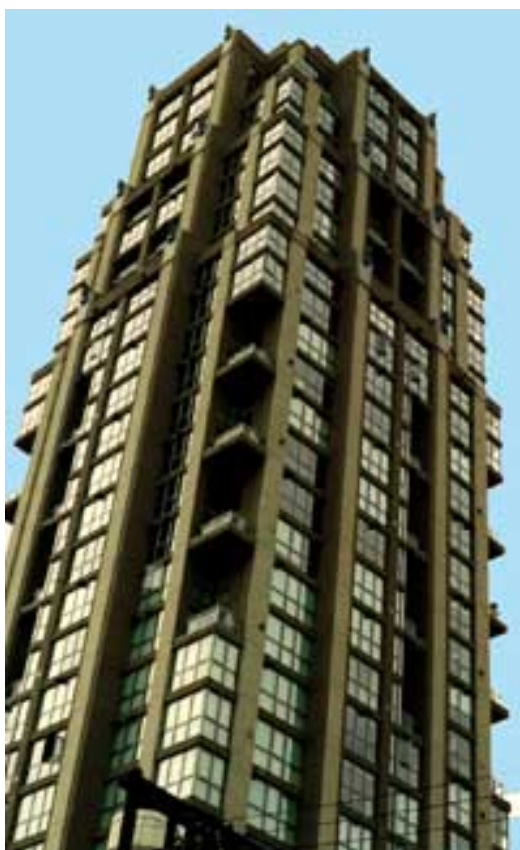
図-3 EcoSmart コンクリートが使用された 30 階建て高層マンション（カナダ、Vancouver 市） A high-rise residential unit where EcoSmart concrete was used
